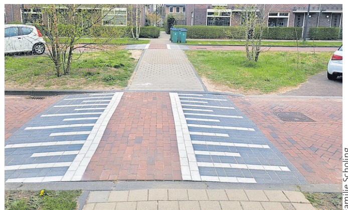
■ Het ontbrak duidelijk aan een 'timmermansoog' bij aanleg van deze drempels.
